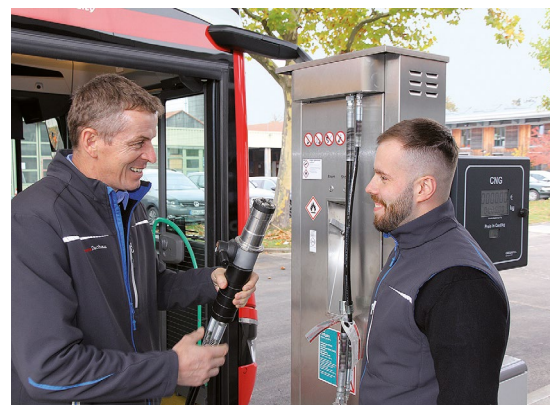
Nehmen die neue Anlage in Augenschein: Betriebsleiter Paul Fottner mit einem seiner Fahrdienstleiter
